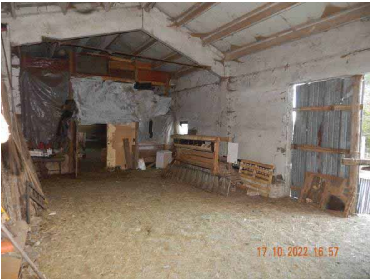
Foto 7 –Interno dell'immobile oggetto di causa adibito a deposito – Corpo B
