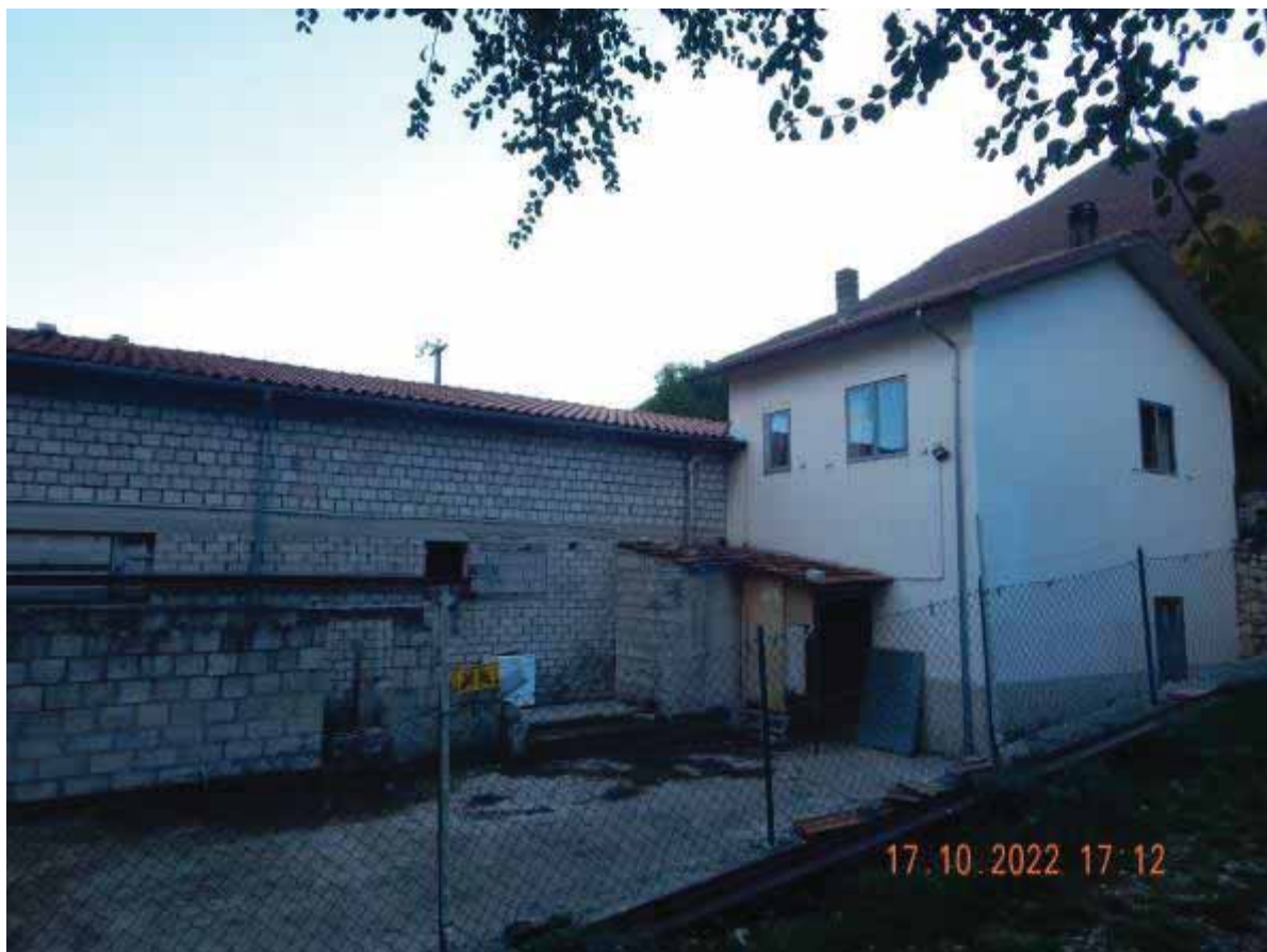
Foto 9 – Particolare dell'esterno e della struttura adibita ad abitazione – Corpi A e C e vano C.T.
