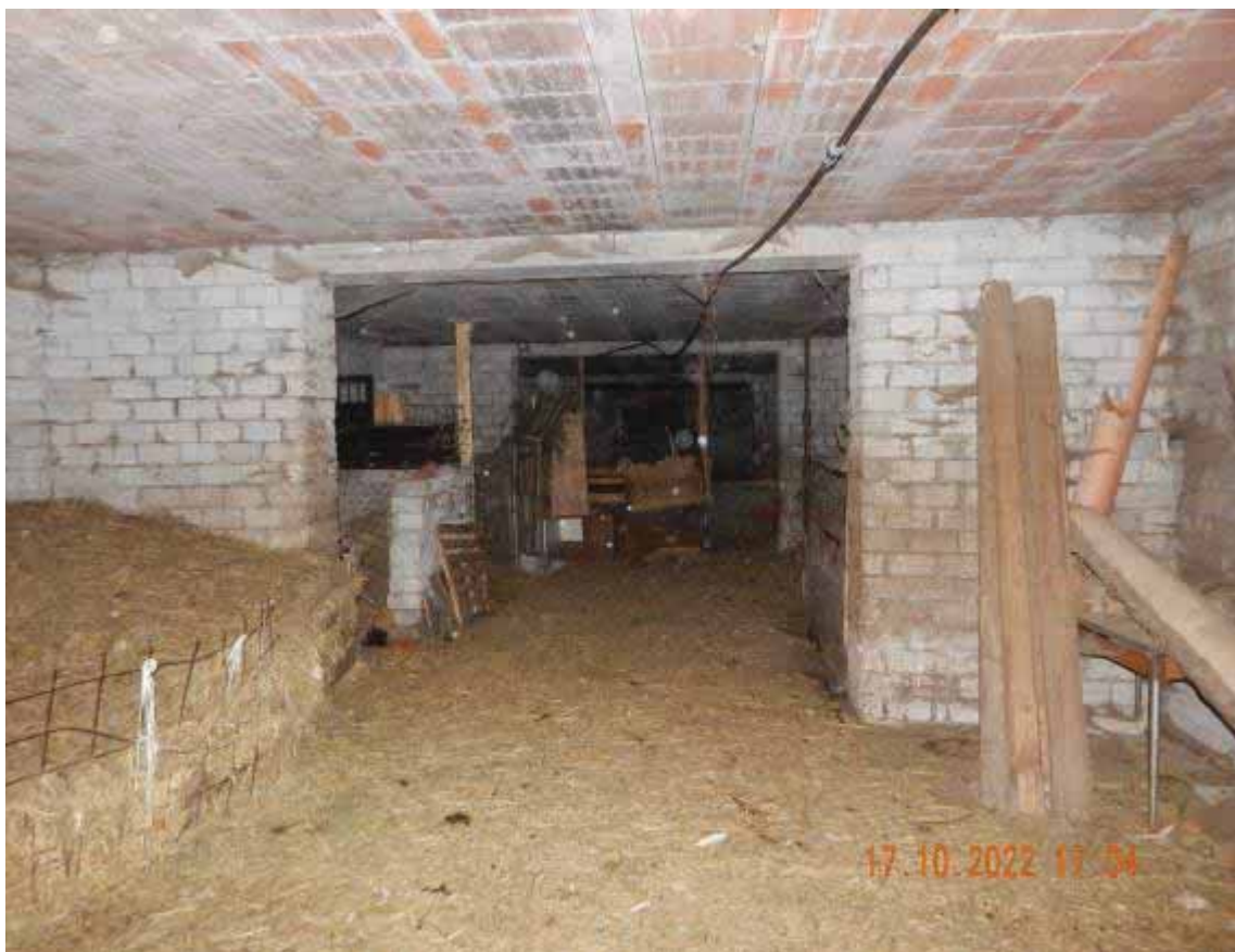
Foto 8 –Interno dell’immobile oggetto di causa adibito a stalla – Corpo A
