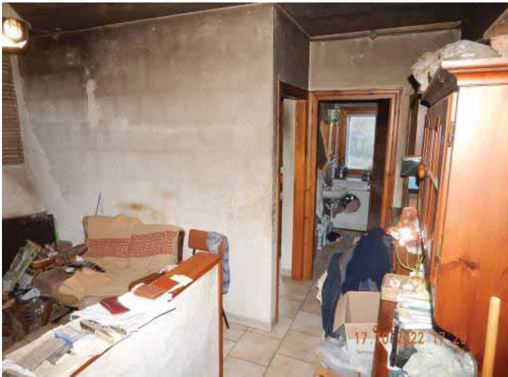
Foto 13 – Corridoio al piano primo
