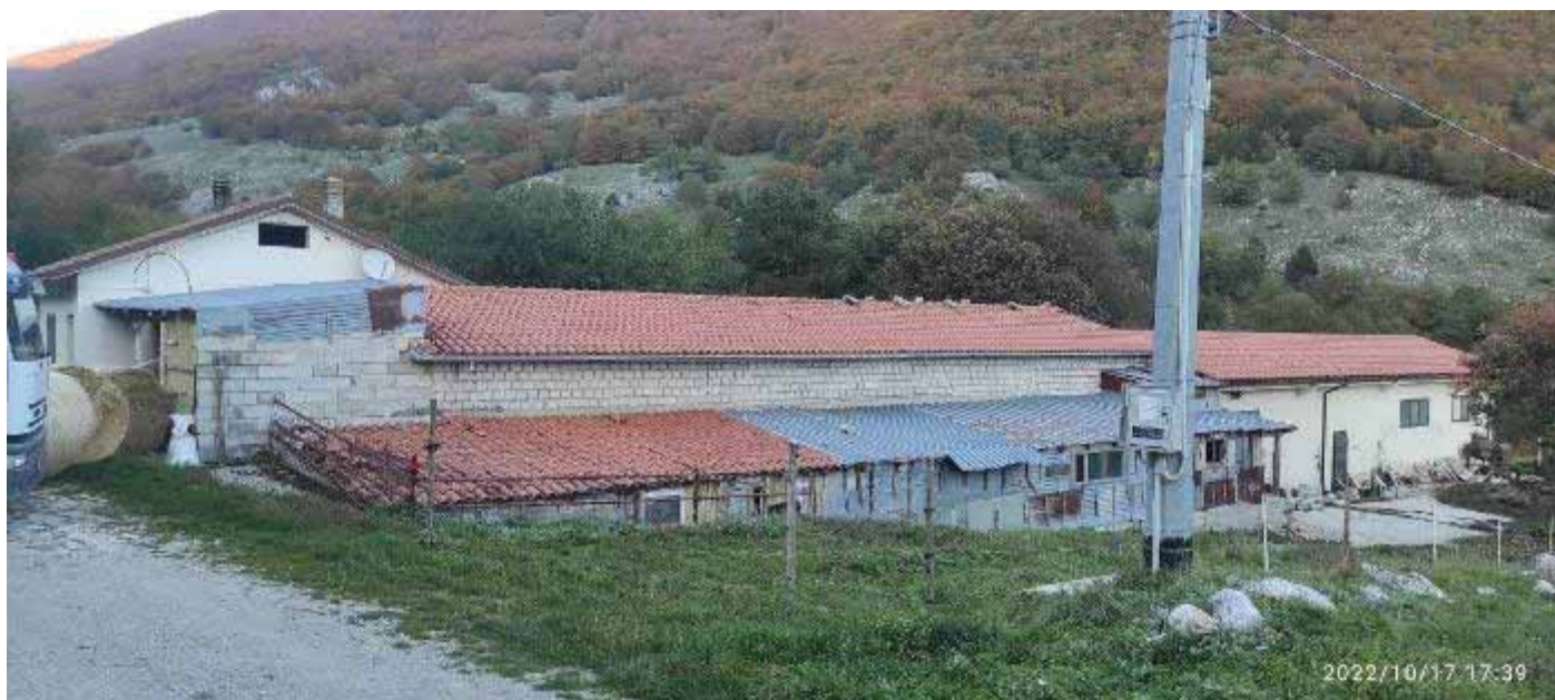
Foto 4 – Immobile oggetto di causa, vista dal lato sud. L'immobile si sviluppa in lunghezza sulla direttrice Est-Ovest
