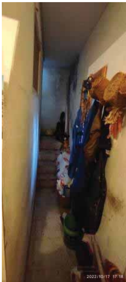
Foto 11 –Scala di collegamento tra il piano terra ed il piano primo
