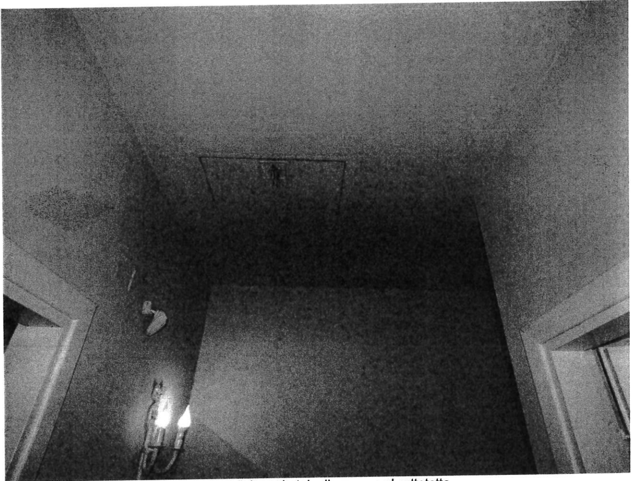
19 - Piano Primo - botola di accesso al sottotetto
