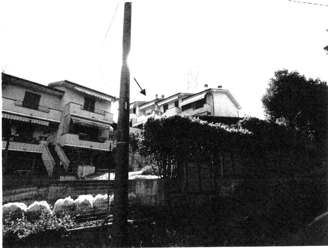
7 - Vista dalla Strada Comunale
