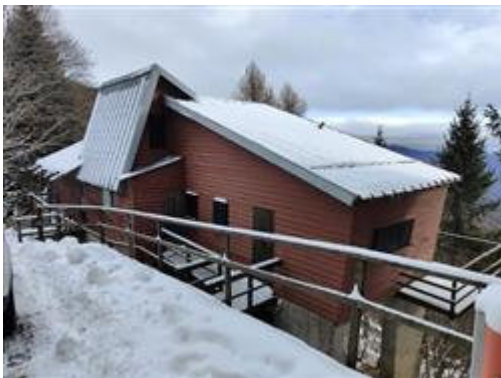
Prospetto da via di accesso e ingresso mapp. 491
