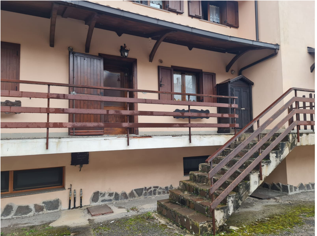
Estratto fotografico appartamento sito nel comune di Castel Di Sangro in Via Teramo n°1, interno 18, piano 2-3 – Immobile n°1
