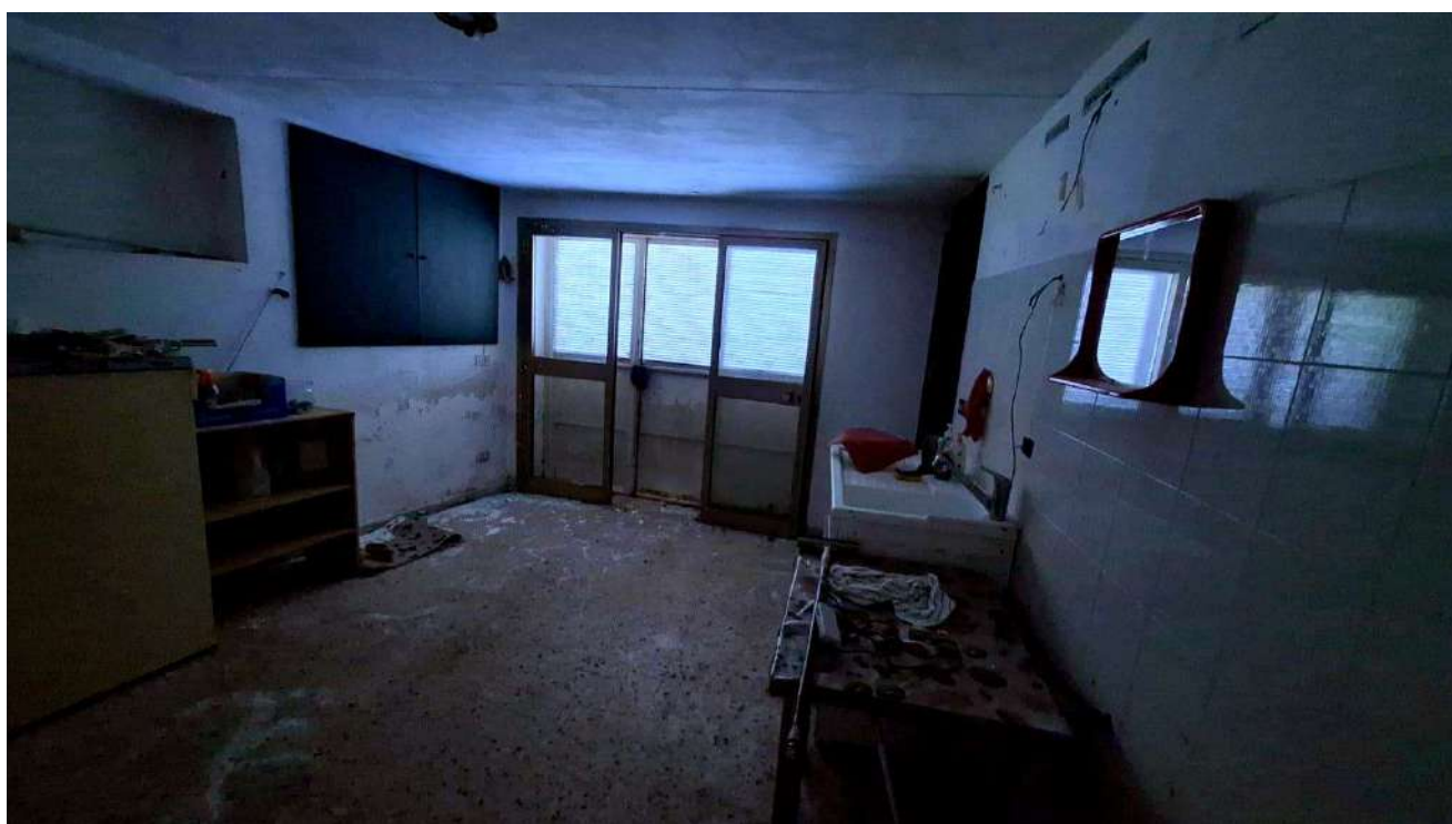
Foto n.10 – PIANO SEMINTERRATO – Interno corpo aggiunto
