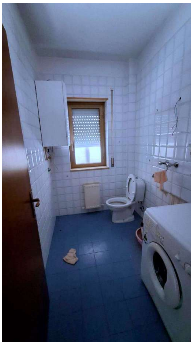
Foto n.16 – PIANO TERRA– Particolare bagno
