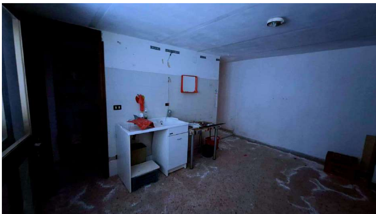
Foto n.12 – PIANO SEMINTERRATO– Corpo aggiunto, Particolare ripostiglio e ingresso intercapedine
