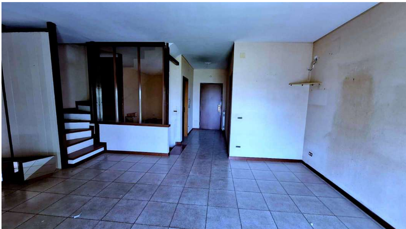
Foto n.13 – PIANO TERRA– Vista sull'ingresso e vano scala
