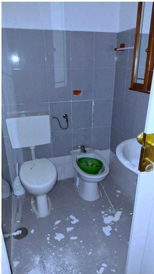
Foto n.11 – PIANO SEMINTERRATO – Particolare bagno corpo aggiunto
