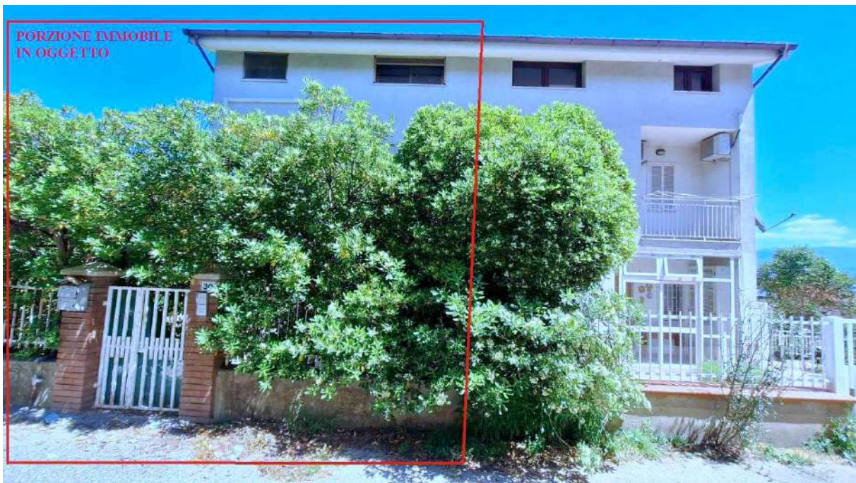
Foto n.1 – Vista prospettica ingresso pedonale su via Milone
