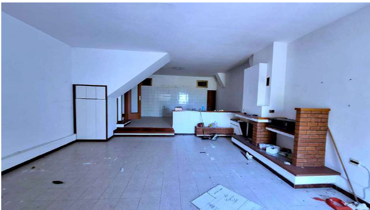
Foto n.7 – PIANO SEMINTERRATO – Vista dall'ingresso
