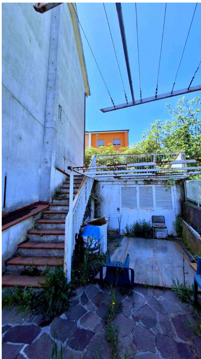
Foto n.5 – Particolare corpo aggiunto
