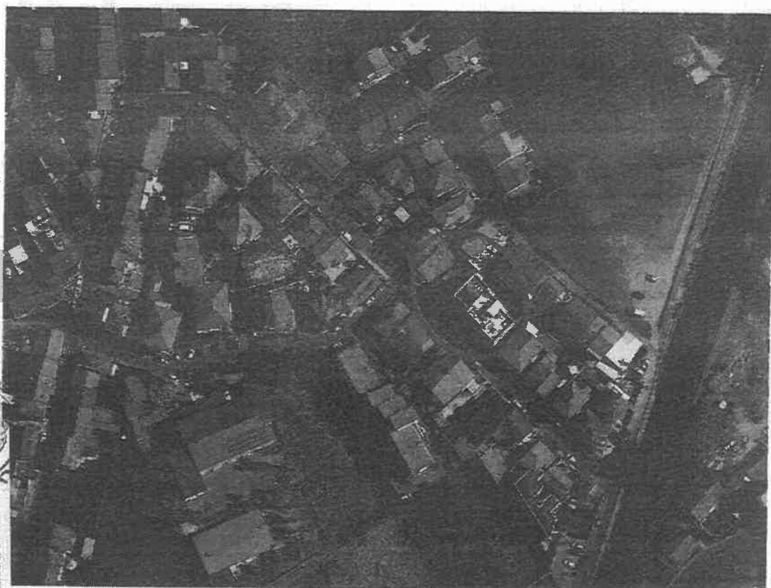
Ubicazione del fabbricato
