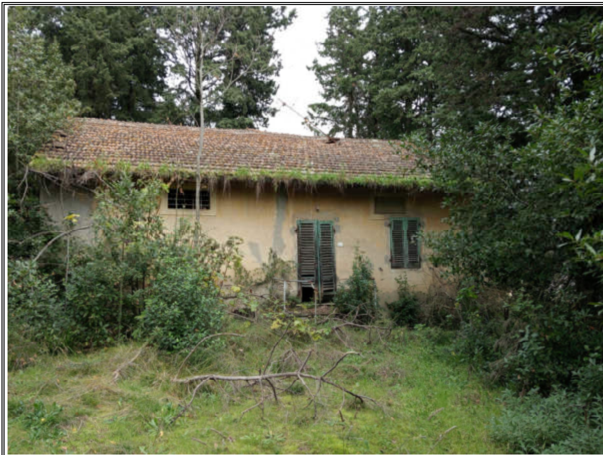
FOTO N° 19 (ESTERNO ACCESSO ABITAZIONE RURALE)
