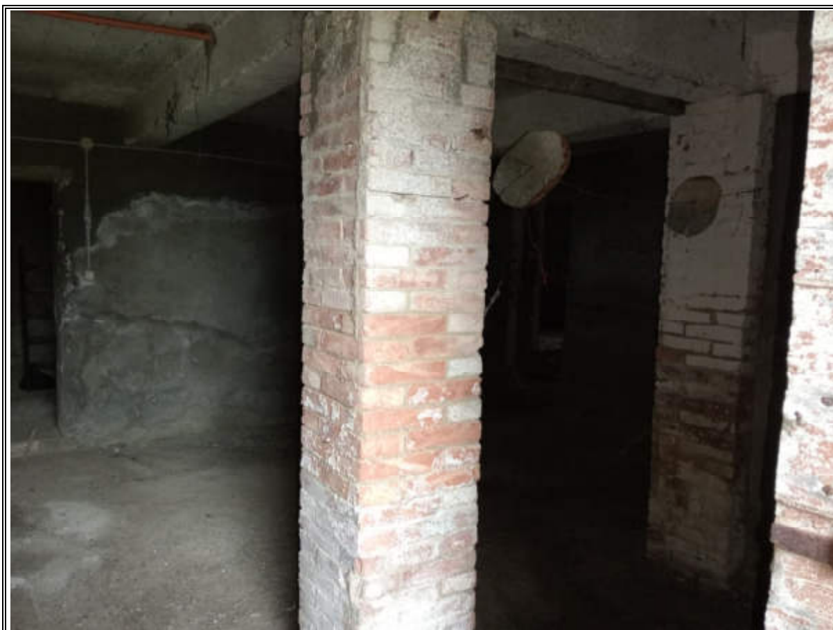
FOTO N° 22 (PIANO SEMINTERRATO – CANTINA ABITAZIONE RURALE)
