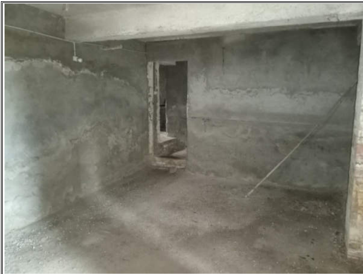
FOTO N° 23 (PIANO SEMINTERRATO – CANTINA ABITAZIONE RURALE)
