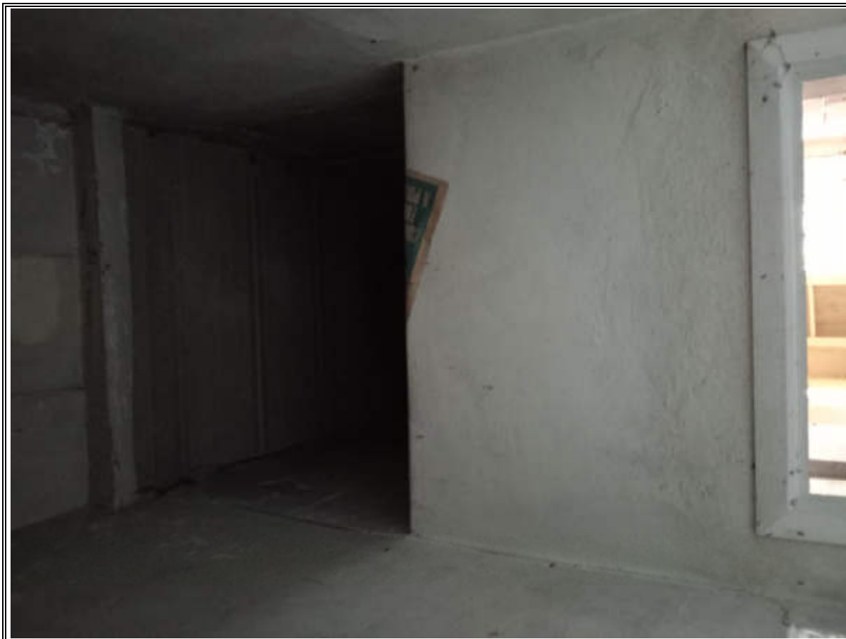
FOTO N° 33 (PIANO TERRENO – PALCO MORTO SOPRA BAGNO)
