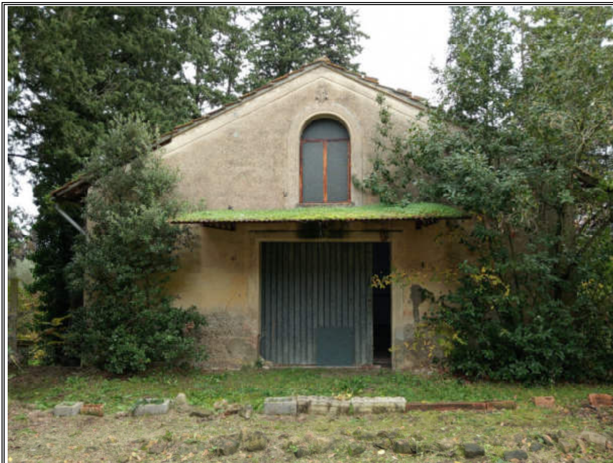
FOTO N° 7 (ESTERNO LOCALE AGRICOLO PIANO TERRENO)
