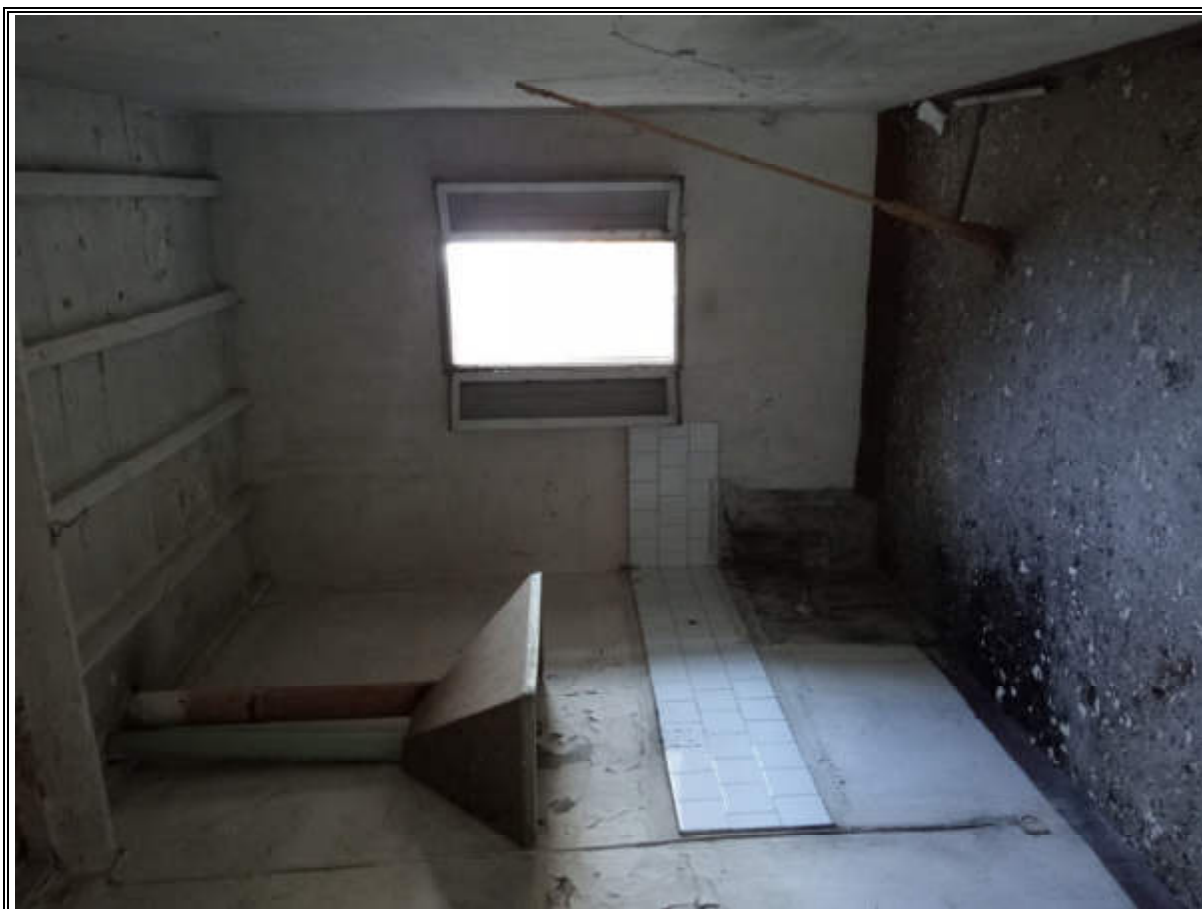
FOTO N° 30 (PIANO TERRENO – CUCINA ABITAZIONE RURALE)
