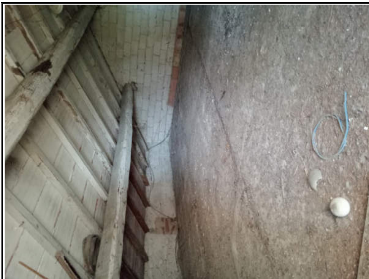
FOTO N° 40 (PIANO SOTTOTETTO ABITAZIONE RURALE)
