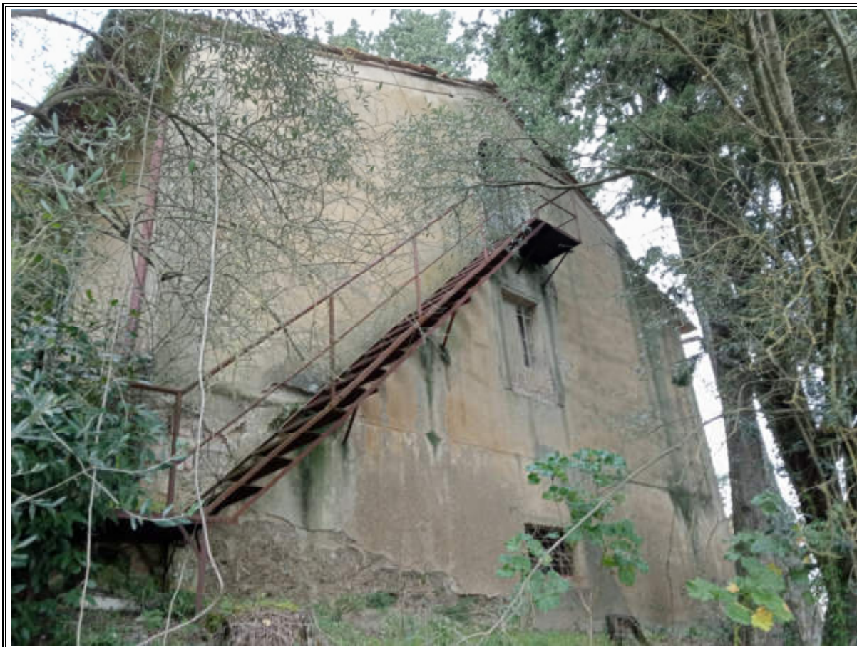
FOTO N° 17 (SCALA ESTERNA ACCESSO SOTTOTETTO)
