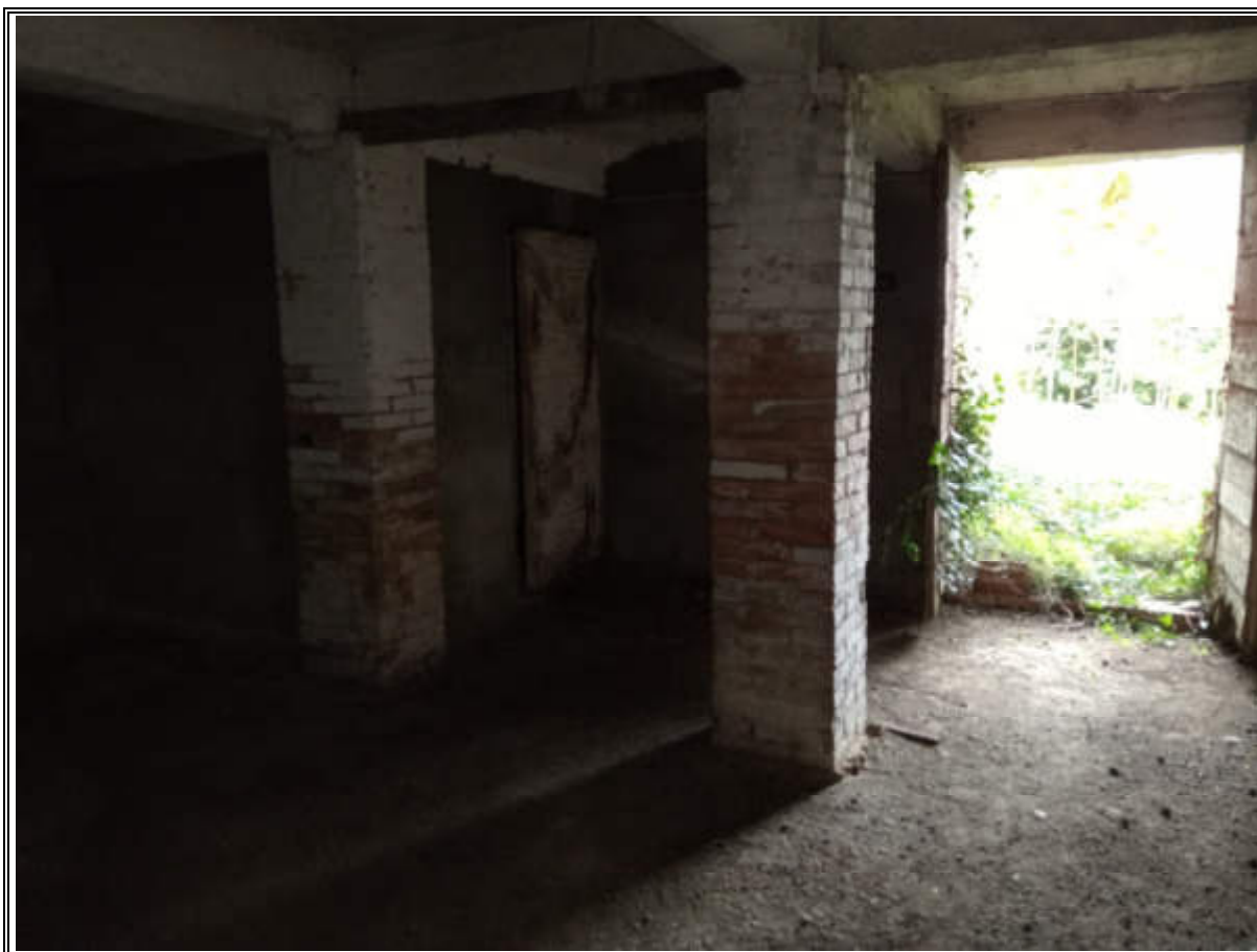
FOTO N° 24 (PIANO SEMINTERRATO – CANTINA ABITAZIONE RURALE)
