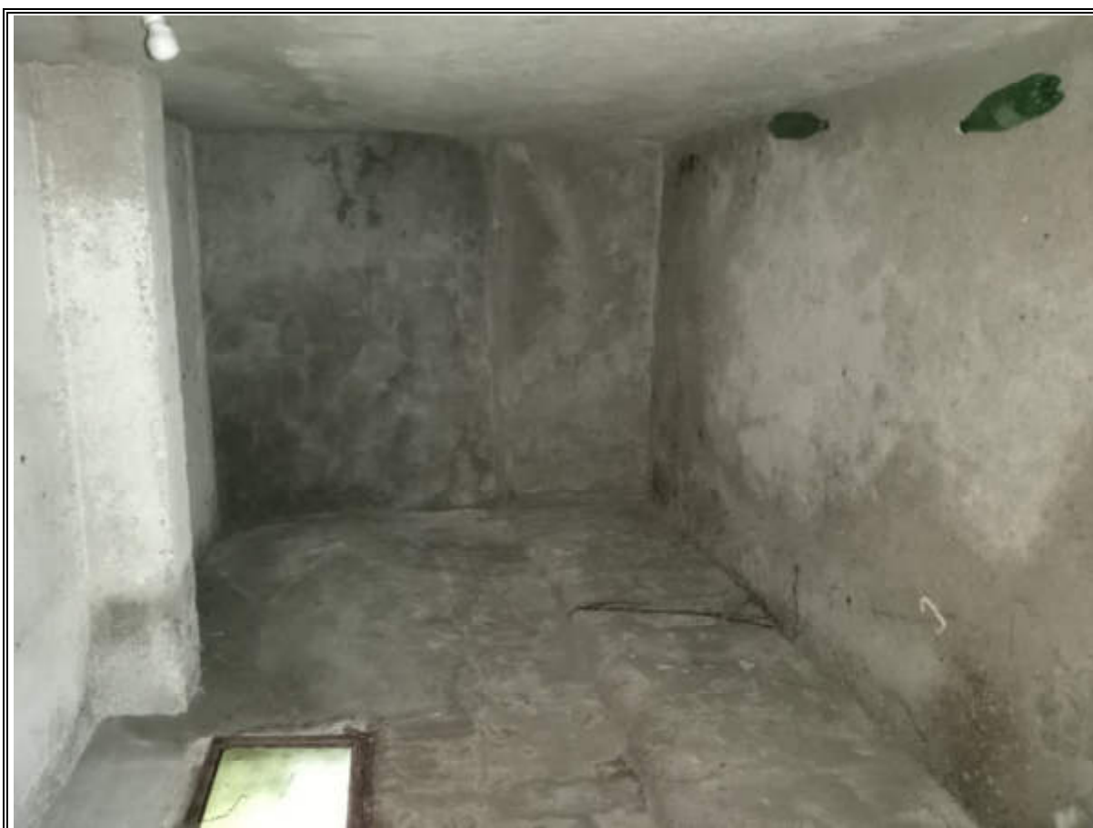
FOTO N° 26 (PIANO SEMINTERRATO – CANTINA ABITAZIONE RURALE)
