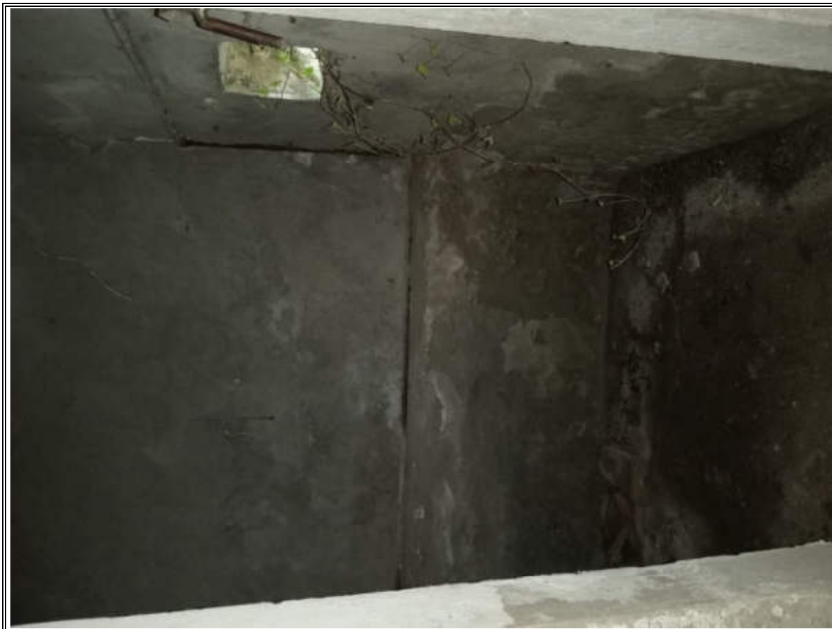
FOTO N° 25 (PIANO SEMINTERRATO – RIPOSTIGLIO ABITAZIONE RURALE)
