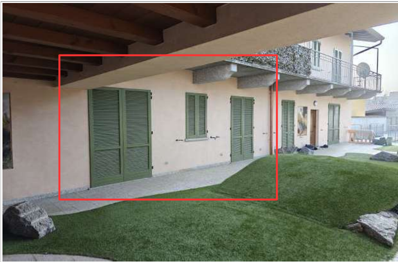
La porzione di facciata relativa al bilocale
