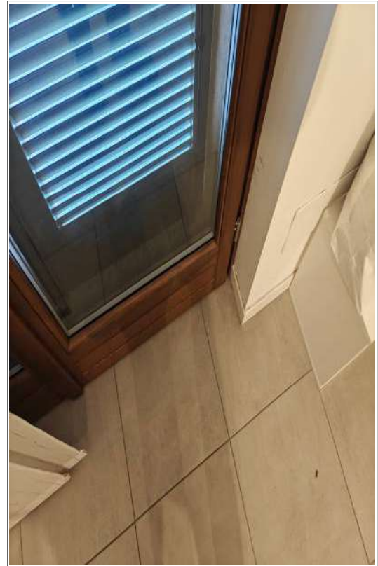
Particolare dei serramenti esterni
