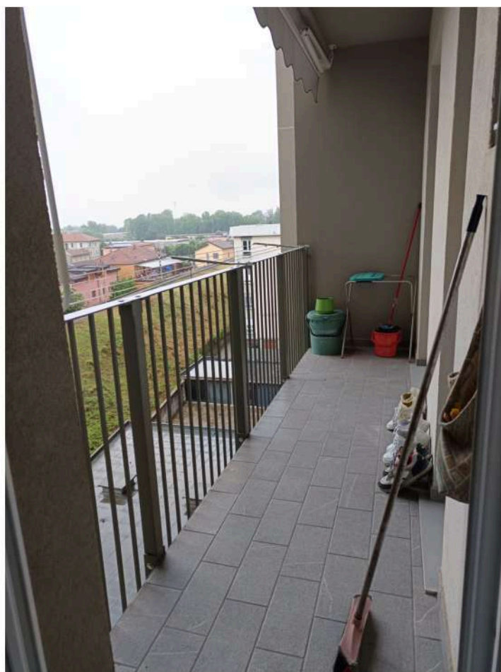
BALCONE SU CORTILE INTERNO
