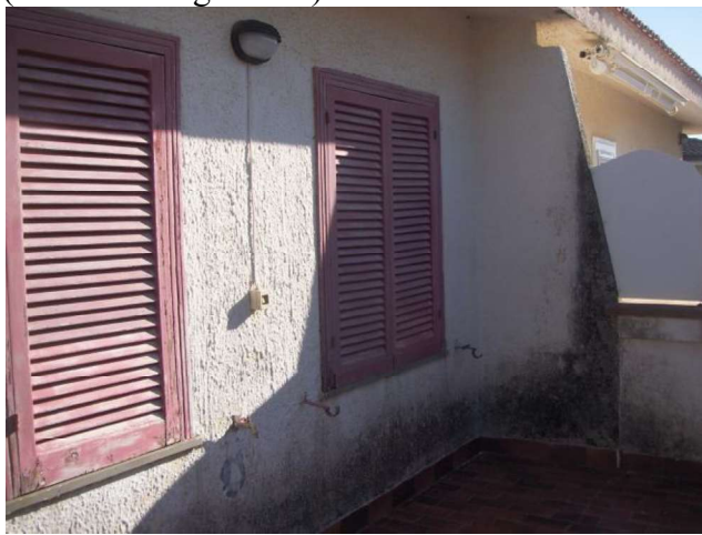
(foto 4: vista area esterna)
