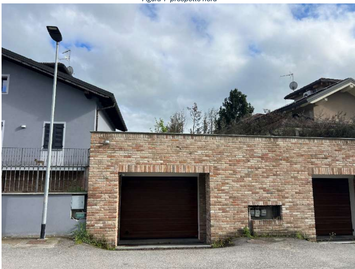
Figura 2 - prospetto nord ingresso autorimessa (a sinistra)
