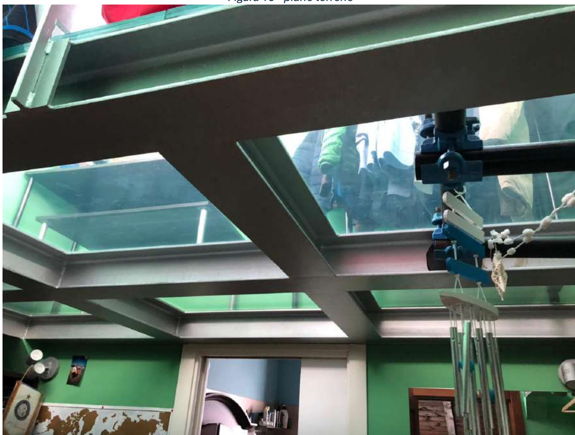
Figura 20 soppalco piano sottotetto
