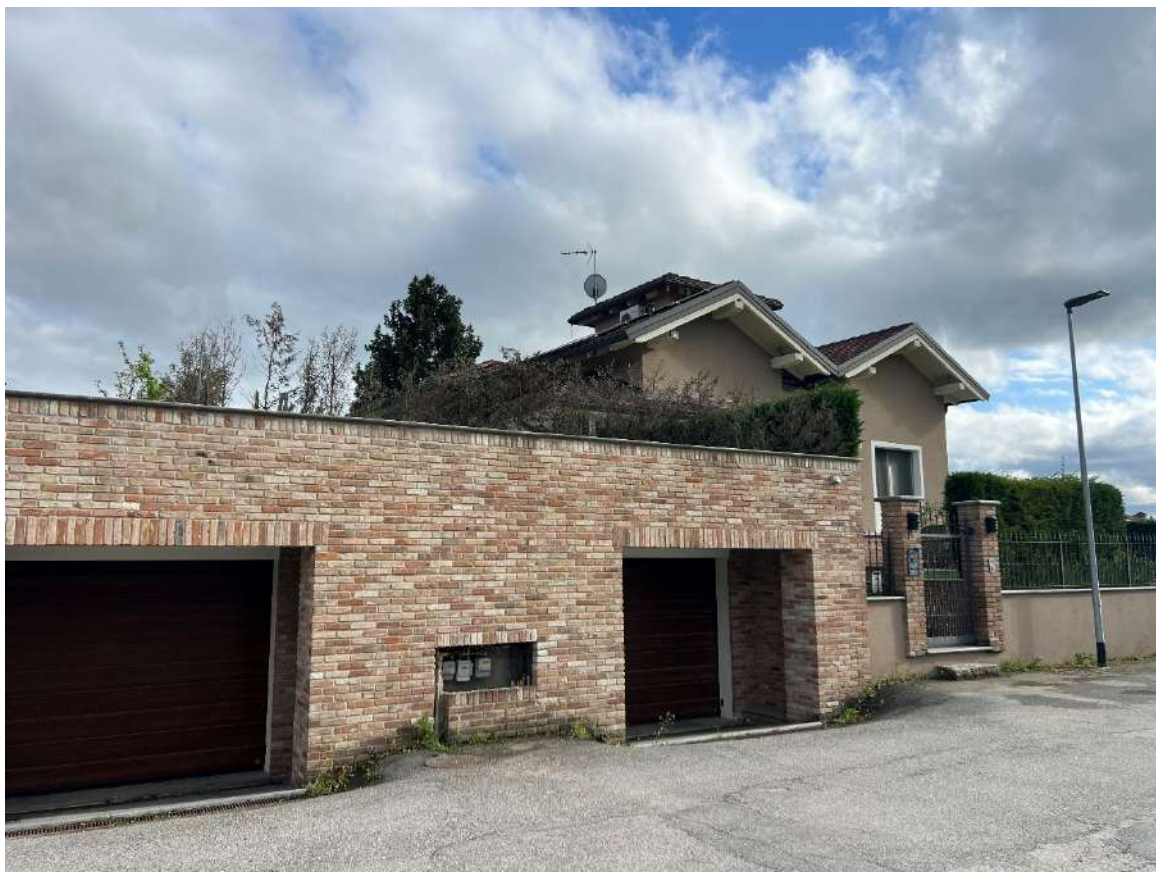
Figura 3 prospetto nord ingresso box (a destra)
