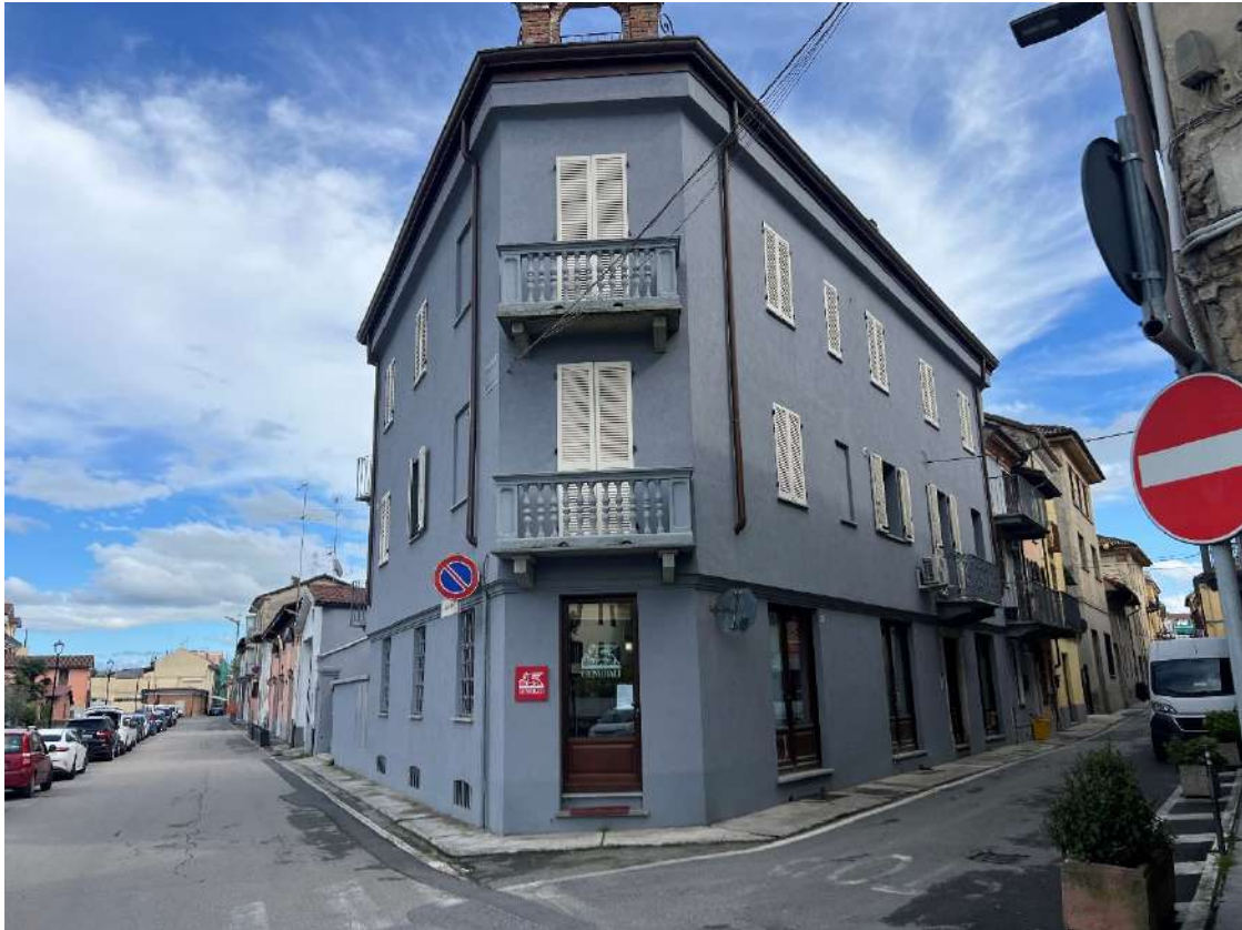
Figura 1 VEDUTA GENERALE DELLO STABILE
