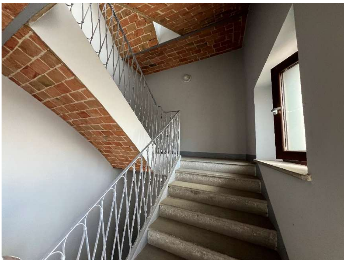
Figura 3 vano scala condominiale
