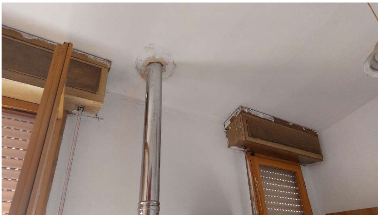
Cucina, scarico stufa a pellet
