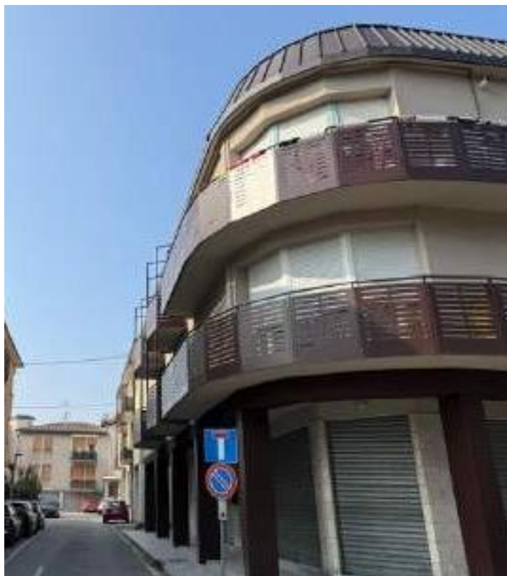
Il fabbricato sulla destra e via Santa Marta
