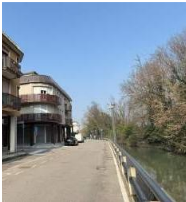
Vista del fabbricato da via Tergola
