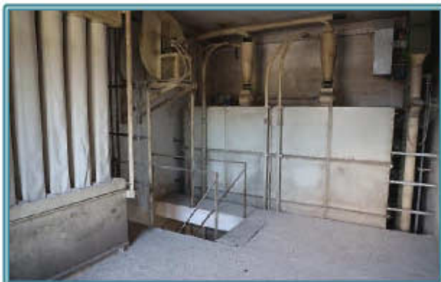
Figura 37 Deposito 4 (piano secondo sottotetto)
