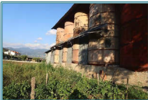
Figura 45 Silos posizionati in aderenza al fabbricato (sub. 4)
