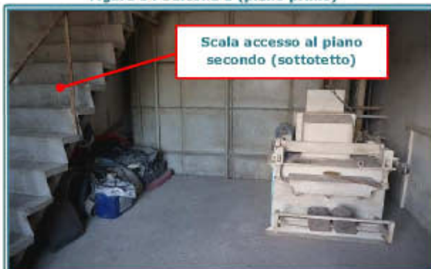
Figura 36 Deposito 2 (piano primo)
