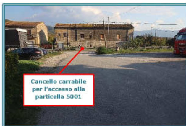
Figura 17 Individuazione ingresso alla particella 5001
