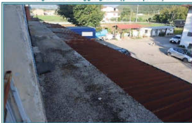
Figura 34 Balcone 1 (piano primo)
