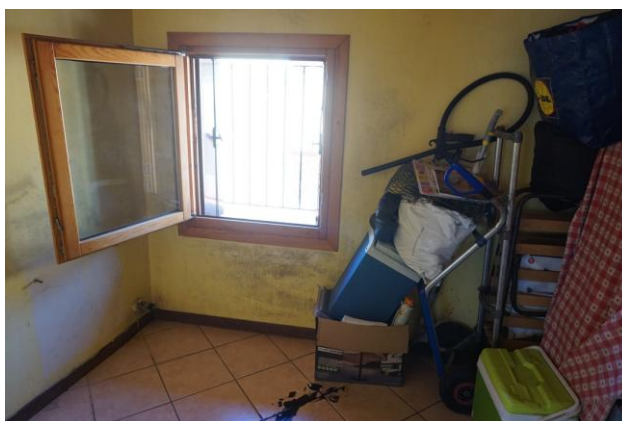
Piano secondo – Soffitta a sud
