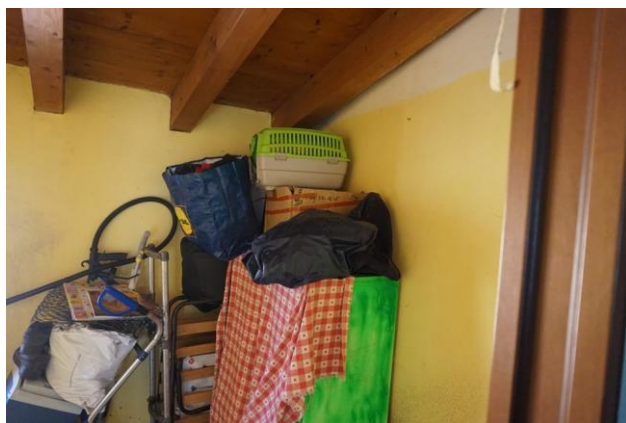
Piano secondo – Soffitta a sud
