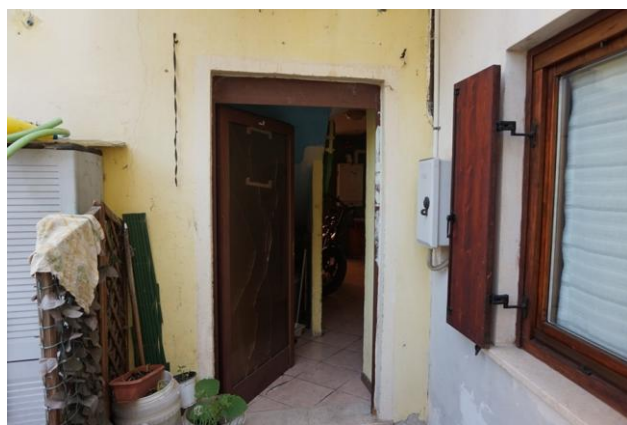
Particolare ingresso da corte comune ad est
