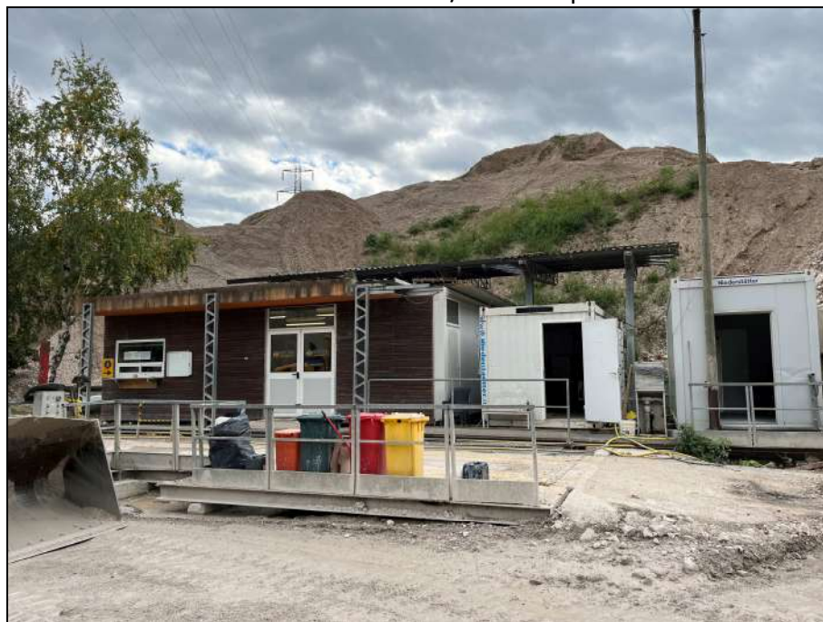
Vista baracche uffici/servizi e pesa
