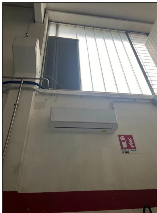
D.6. CLIMATIZZATORE IN POMPA DI CALORE (MODELLO ANALOGO A D.7 E D.8.)
