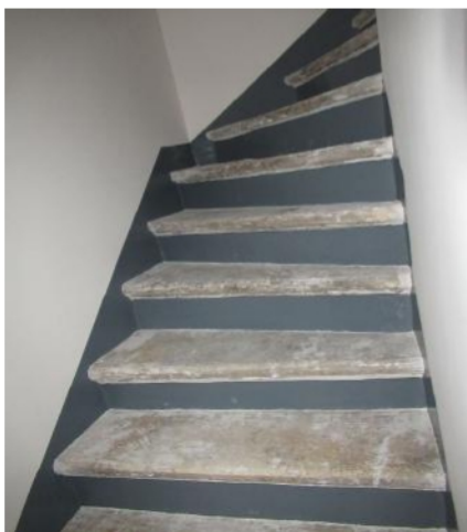
Foto 11 – Scala di accesso al piano 2°
