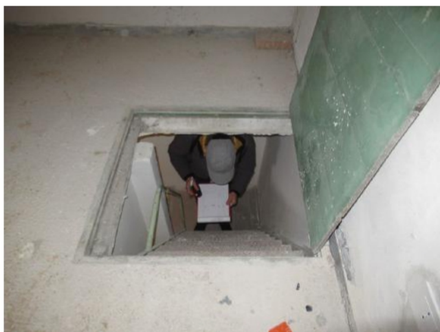
Foto 19 – Botola di accesso al piano sottotetto
