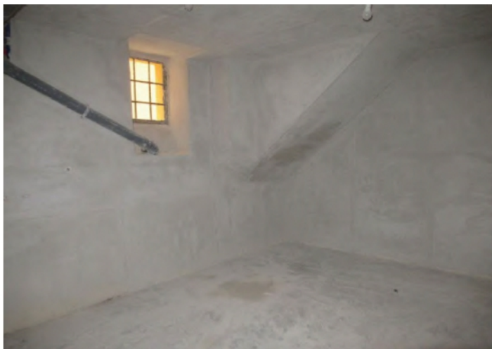
Foto 25 – Interno garage sub. 6
