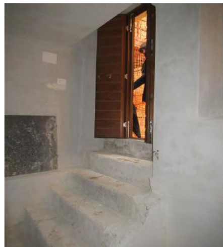
Foto 26 – Interno garage sub. 6
