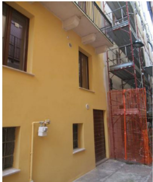
Foto 4 – Veduta esterno fabbricato
