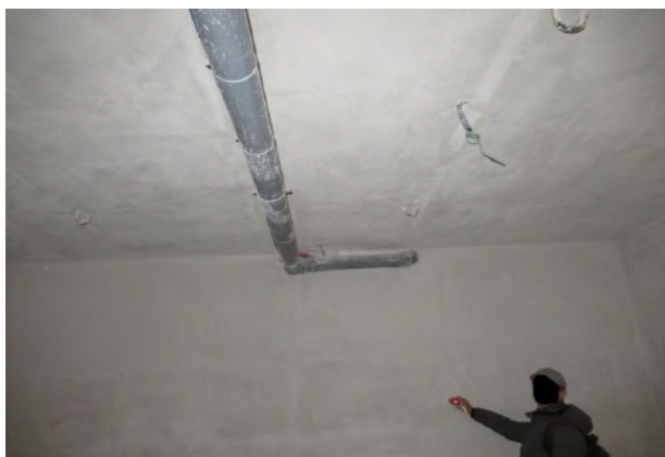
Foto 27 – Interno garage sub. 6
