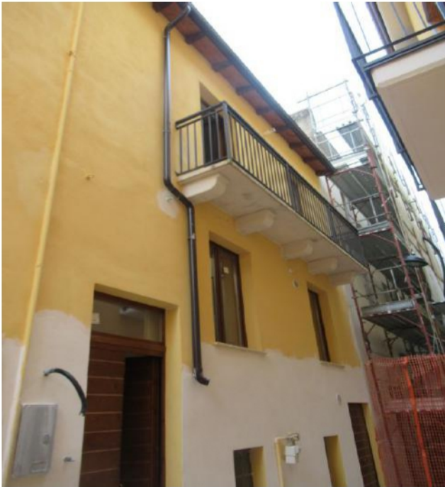
Foto 1 - Esterno fabbricato – Portone ingresso
