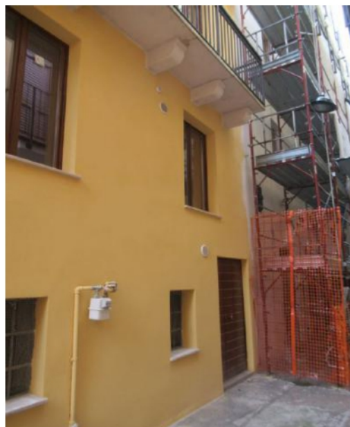
Foto 4 – Veduta esterno fabbricato
