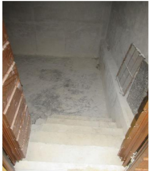
Foto 24 – Scala di accesso al garage
