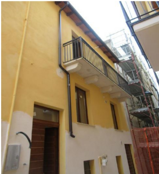
Foto 1 - Esterno fabbricato – Portone ingresso
