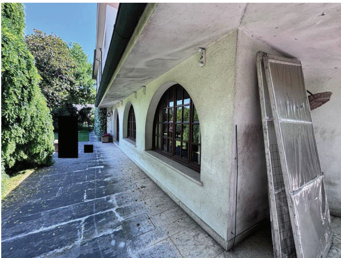
FOTO 4• vista da Nord-Ovest – ampliamento
