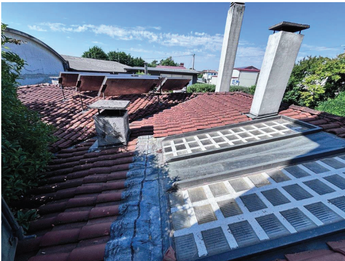
FOTO 15• vista su copertura dell'ampliamento
