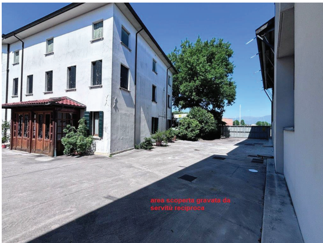
FOTO 11• vista da Sud-Est -
