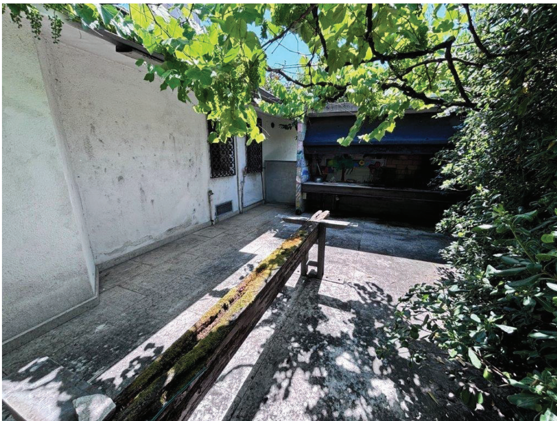
FOTO 5• vista da Ovest - ampliamento e area scoperta
