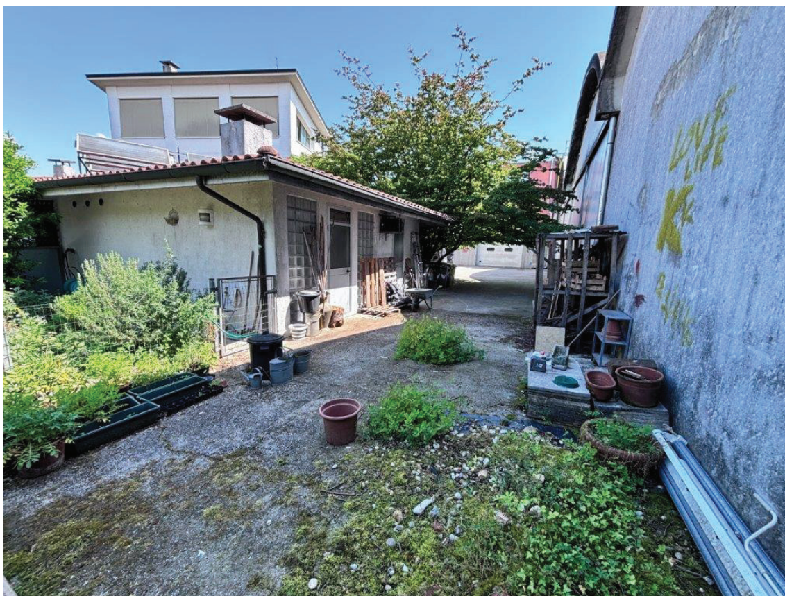
FOTO 6• vista da Sud-Ovest - corpo accessorio e area scoperta
