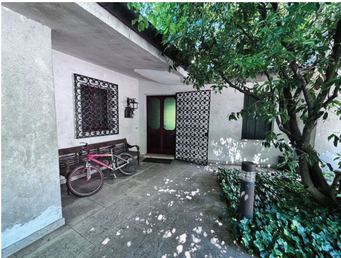
FOTO 9• vista ingresso lato Sud
