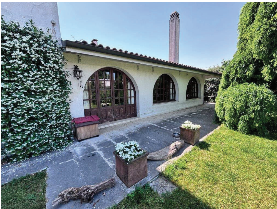
FOTO 2• vista da Nord-Ovest - ampliamento
