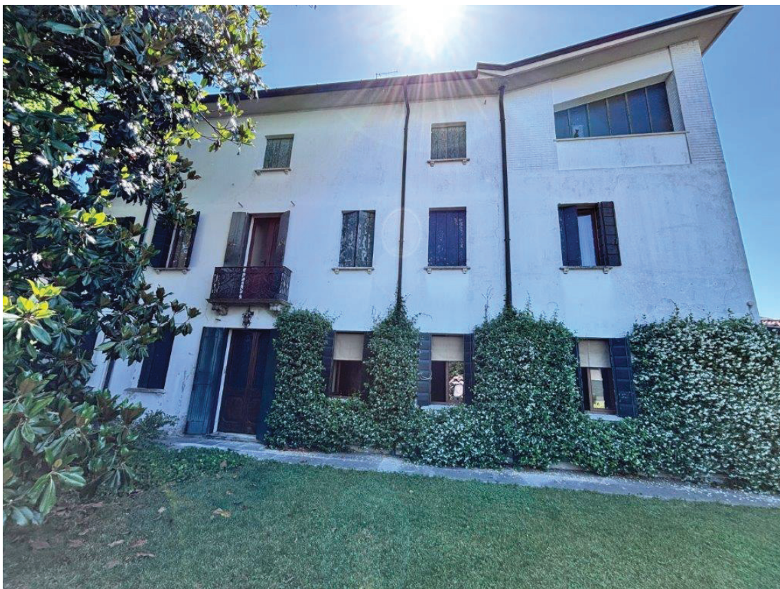
FOTO 1• vista da Nord-Ovest - corpo principale
