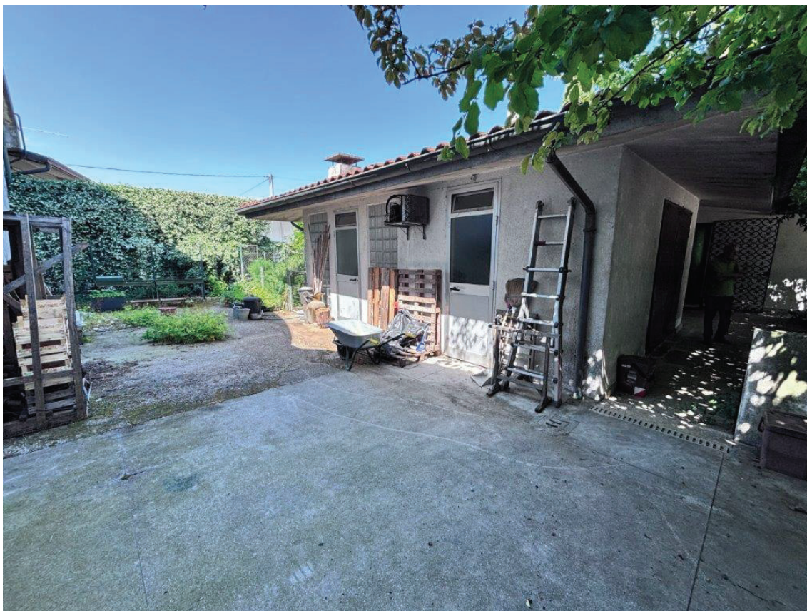
FOTO 7• vista da Sud - corpo accessorio e area scoperta
