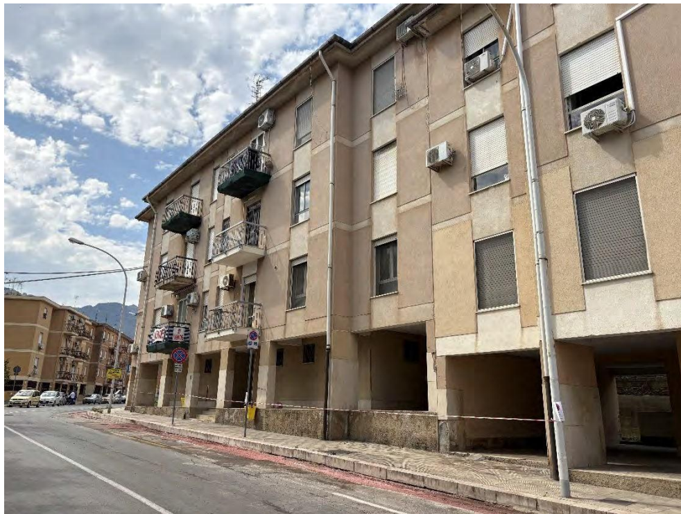
Fotografia 5 – Prospetto angolo via F. Parri n.8
