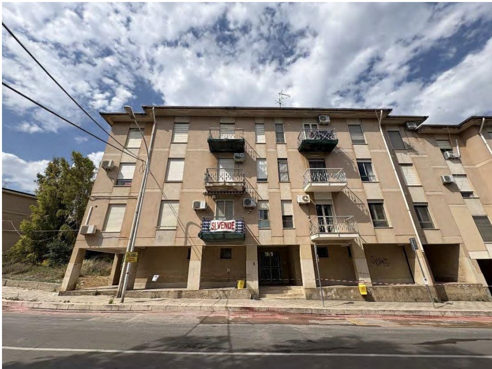
Fotografia 4 – Prospetto frontale via F. Parri n.8
