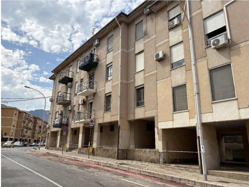
Fotografia 5 – Prospetto angolo via F. Parri n. 8
