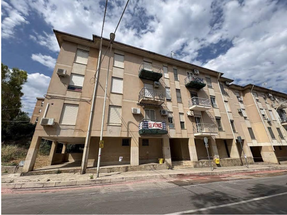
Fotografia 3 – Prospetto angolo via F. Parri n.8
