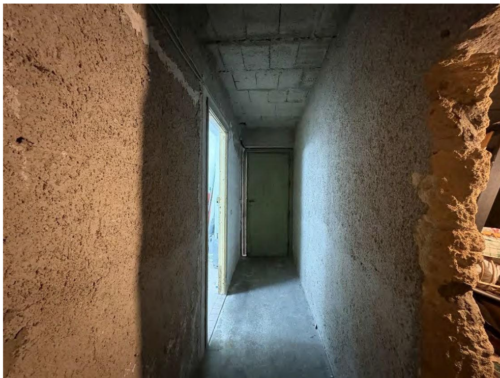
Fotografia 10 – Ingresso magazzino, piano terra, scala D
