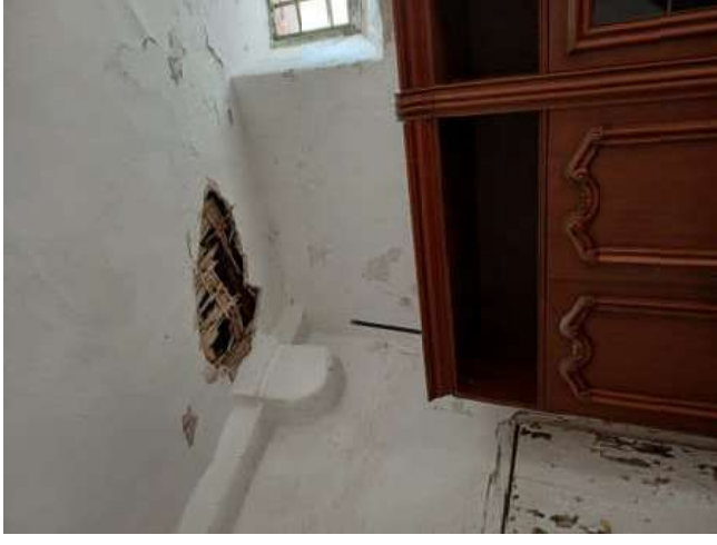
4 - Soffitto atrio comune
