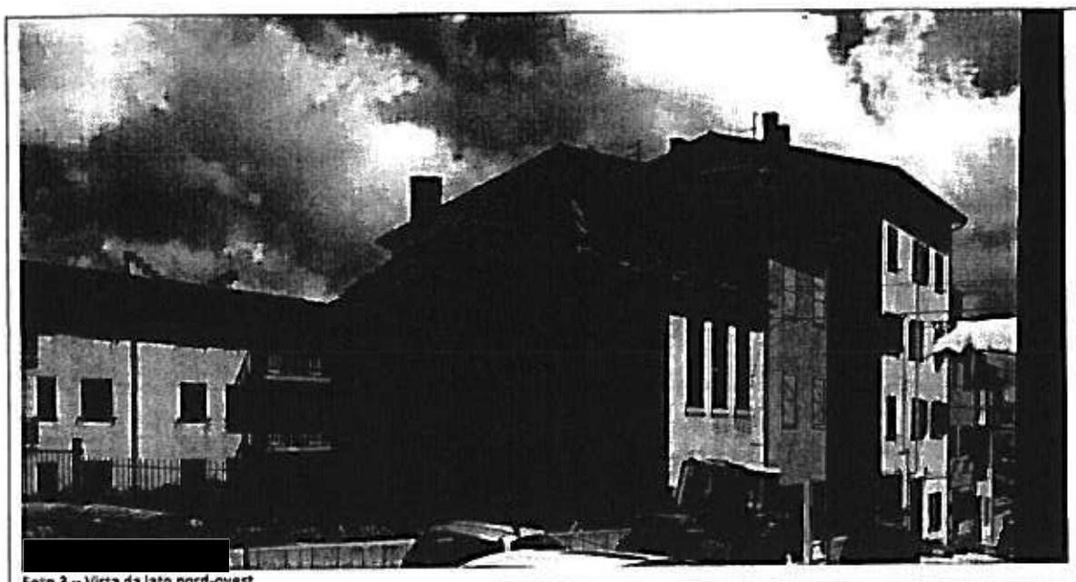
Foto 3 - Vista da lato nord-ovest
