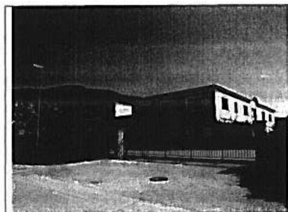
Foto 1 - Vista da nord-ovest
