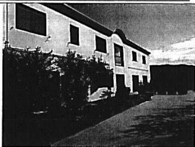
Foto 8 - facciata esterna lato sud uffici e officina
