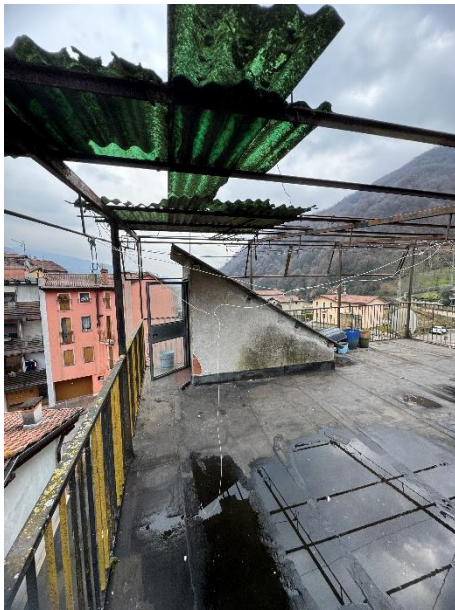
Foto n. 11 – Scala esterna terrazzo
