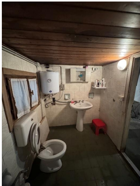
Foto n. 3 – Bagno piano interrato
