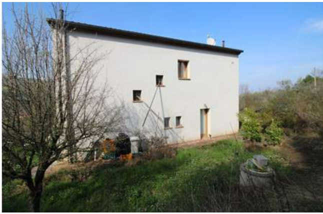
Foto 13: prospetto sud prospiciente lato monte
