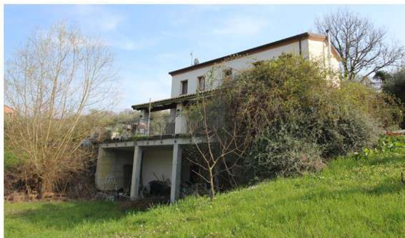
Foto 8: il fabbricato realizzato sul sedime del mappale 198
