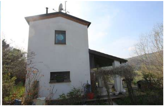
Foto 14: prospetto laterale est
