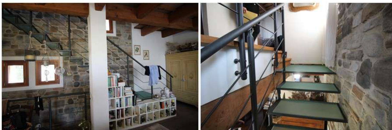
Foto 17-18: scala di accesso al piano primo vista e dettaglio costruttivo
