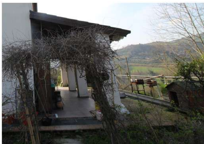
Foto 23: portico lato nord – valle
