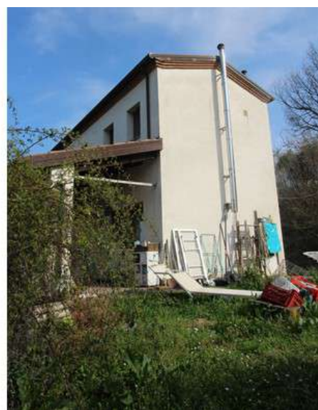
Foto 12: prospetto laterale ovest
