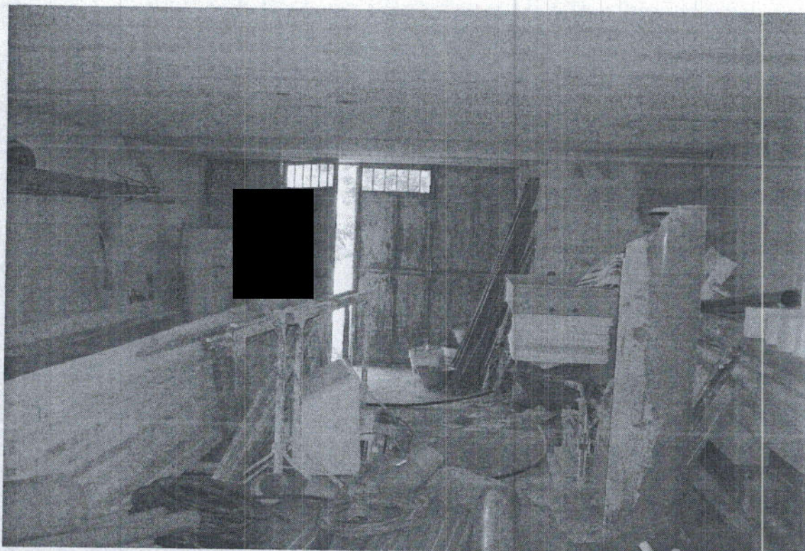
Foto n. 9 Vista interna Garage(lato six)
