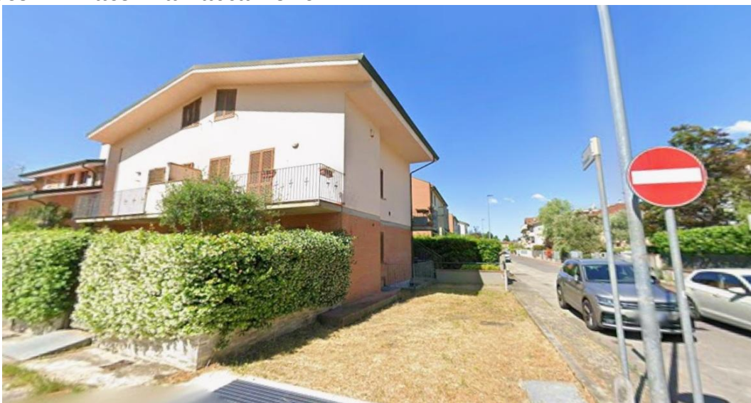
Foto 4 – Lato Via Passamonti
