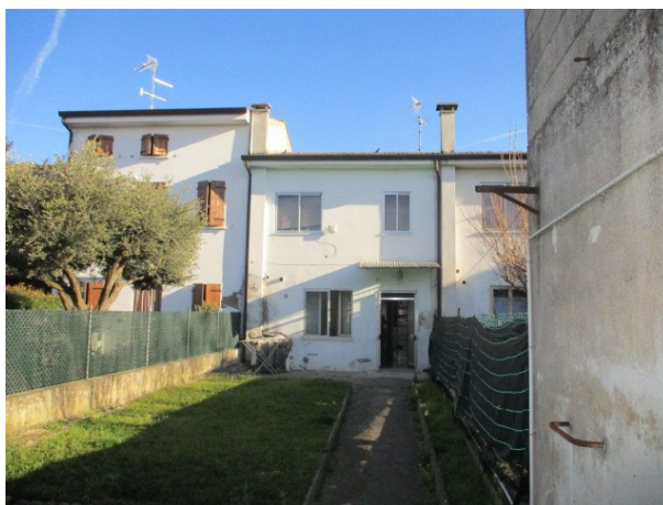
Fronte principale abitazione - corte
