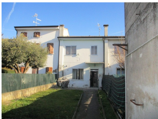
Ingresso abitazione- corte
