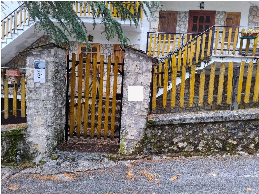
Accesso lotto n. 31 su Via Losanna lato sud-ovest (foto del 02/09/2025)
