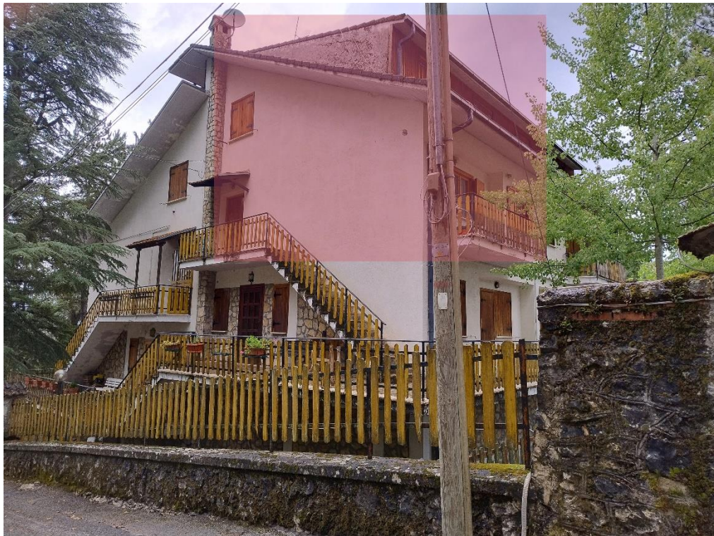
Foto prospetto su Via Losanna - lato sud-ovest (foto del 02/09/2025)
