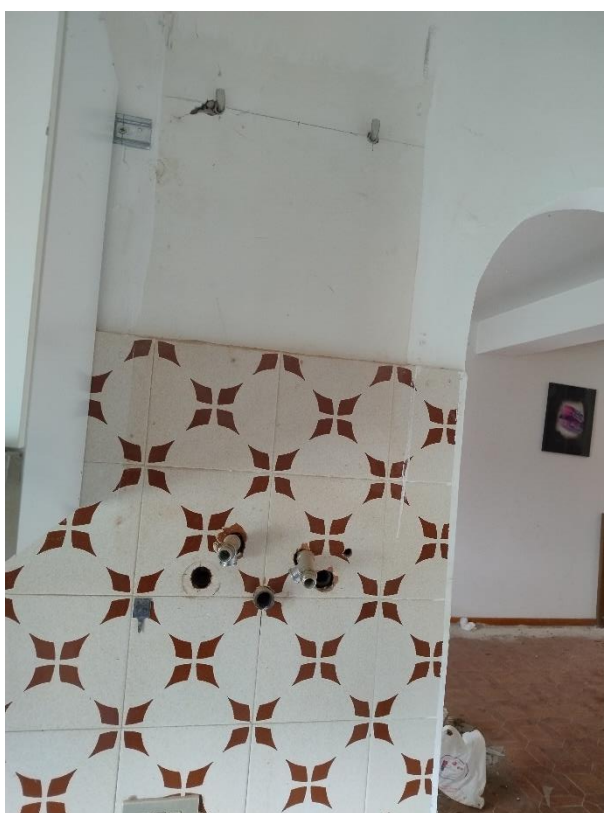
Cucina al piano secondo - lato dove era installata la caldaia murale (foto del 15/10/2025)
