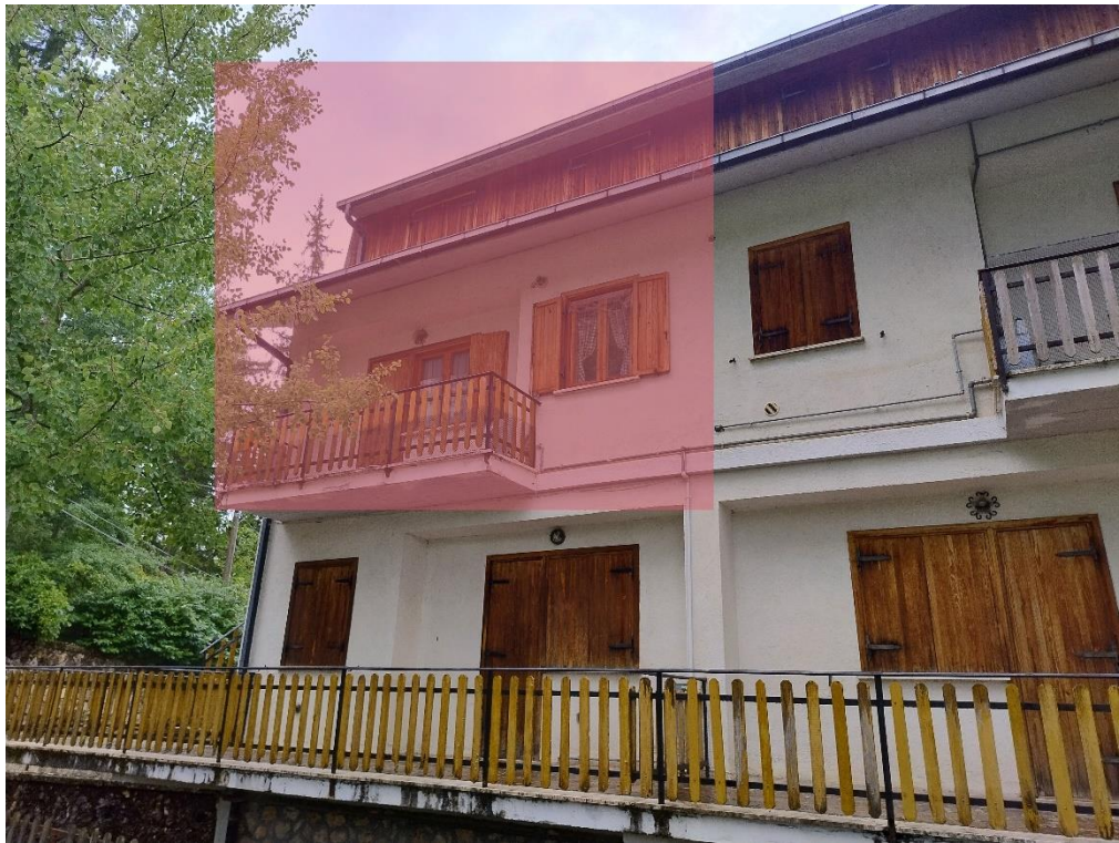
Foto prospetto sul lato sud-est (foto del 02/09/2025)
