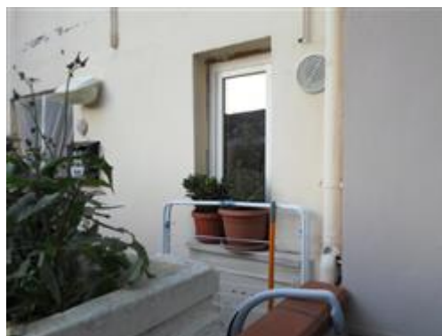
Finestra ripostiglio su parete prospettica
