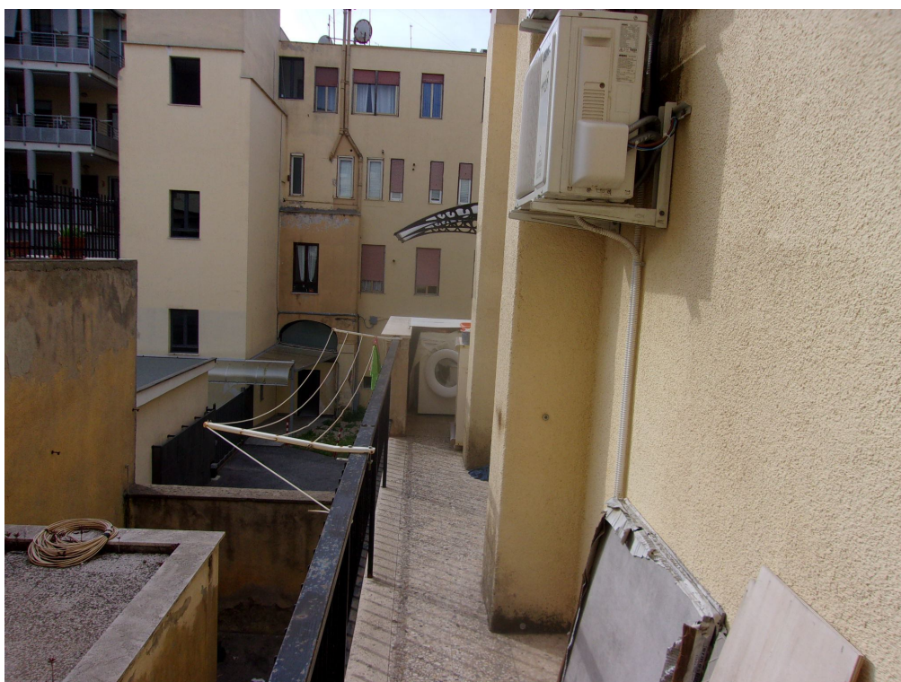
FOTO N. 12 Piano primo – balcone -
