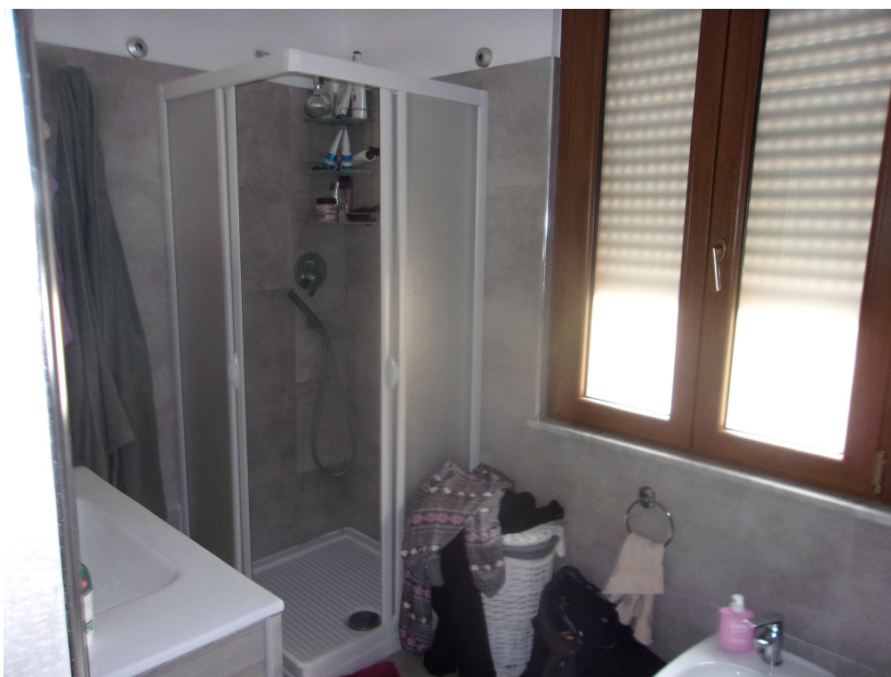
FOTO N. 7 Piano primo – bagno -
