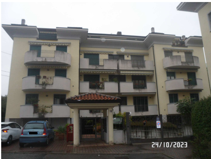
Prospetto verso via E. Gramatica e ingresso comune
