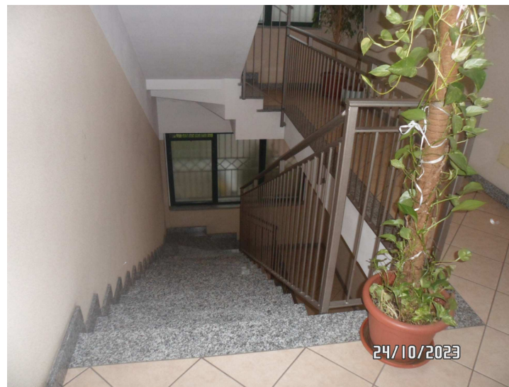
Vano scala comune
