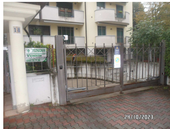
Cancello carraio comune di entrata/uscita box
