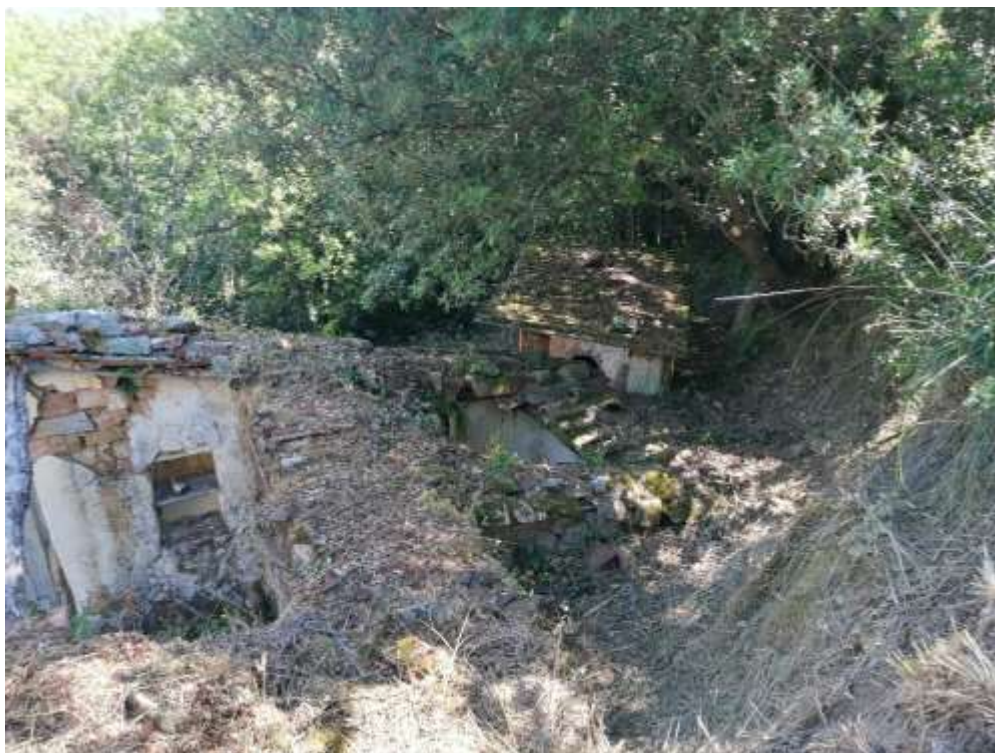
COPERTURE LATO EST E PORTICO
