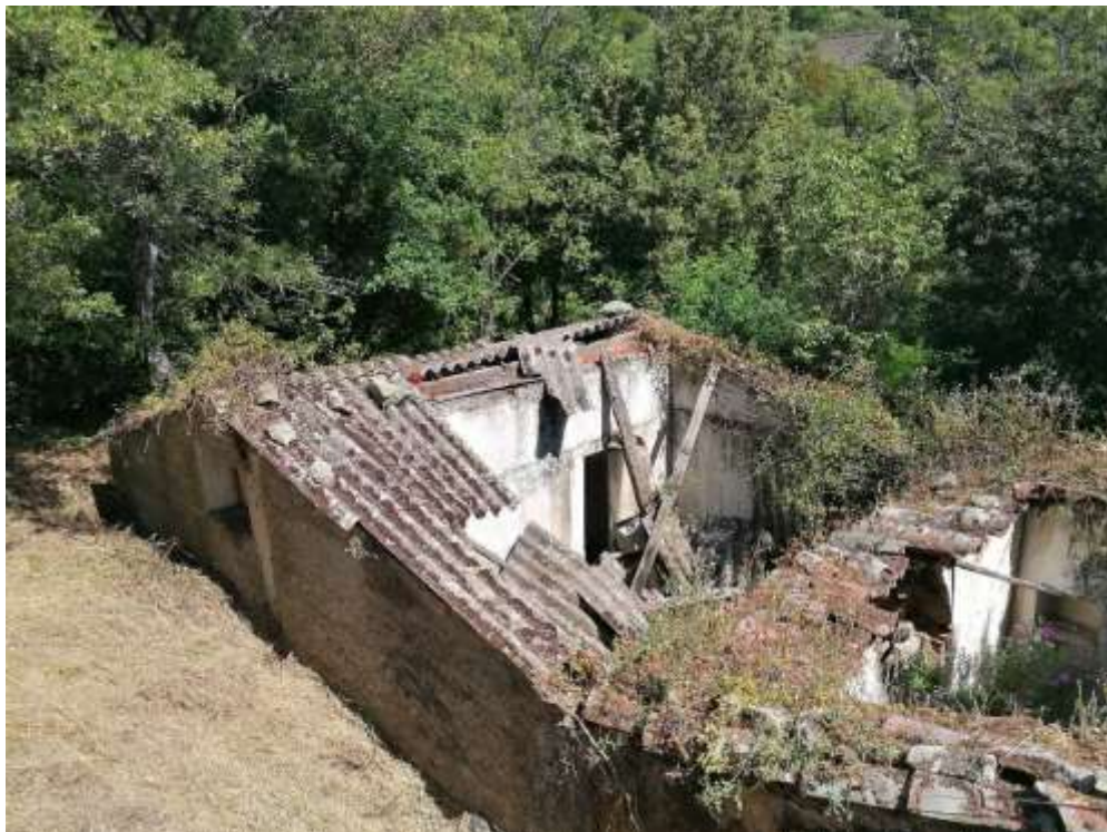
VISTA INTERNO CAMERA CENTRALE
