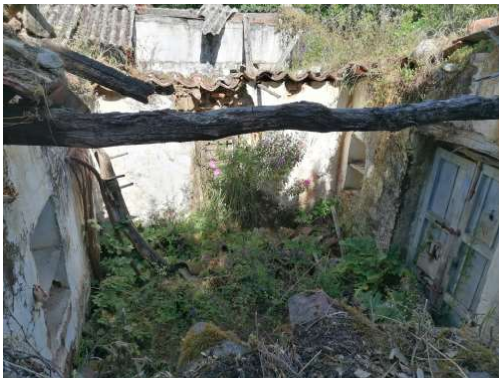
VISTA INTERNO CUCINA
