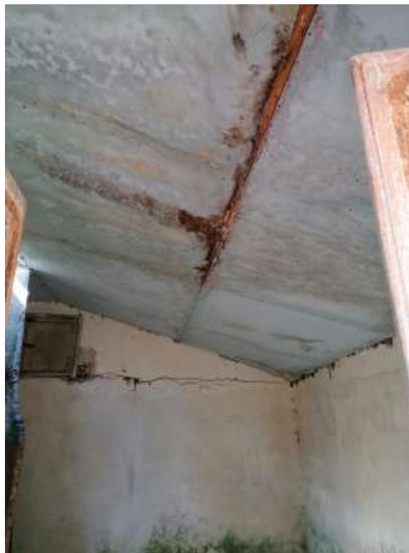
VISTA INTERNO CAMERA OVEST
