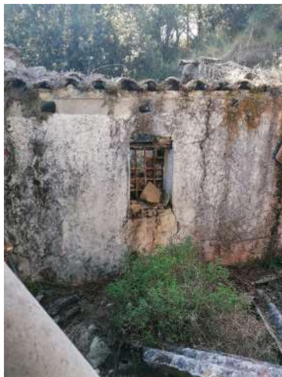
VISTA INTERNO CAMERA CENTRALE
