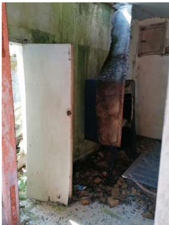
VISTA INTERNO CAMERA OVEST
